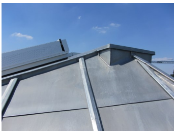
Zinken roevendak. Bij het ontwerp dienen alle aansluitingen zorgvuldig uitgetekend te worden.
