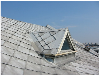
Dakbedekking uit losanges (kleine zinken platen die in elkaar gehaakt worden).
