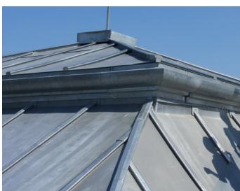
Zinken roevendak. Bij het ontwerp dienen alle aansluitingen zorgvuldig uitgetekend te worden.
