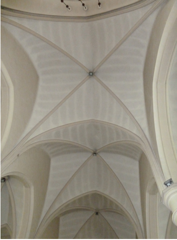
Bij o.a. vloerverwarming kunnen grote thermisch gedreven luchtstromen ontstaan. Deze nemen vuil en stof mee dat zich afzet op o.m. de gewelven. ①
