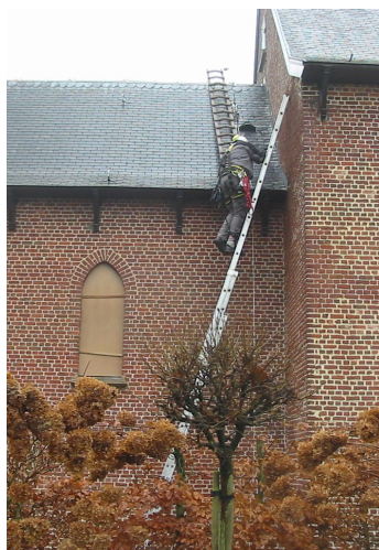
De zolder is bereikbaar met behulp van een ladder, leiladder en de nodige ladderhaken.
