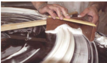
Het trekken van stuclijsten met een profiel. Foto: Guido Everaert, cursus 'Pleister', 2013: 13.
