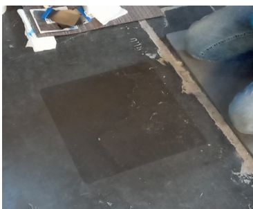
Achtergebleven lijmresten op de ondergrond ③
