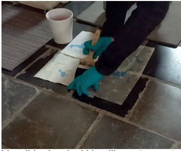
Verwijder hardnekkige lijmresten met een kompres ⑤
