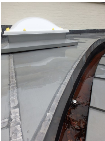
Zinken dakbedekking met lichte golfvorming.
