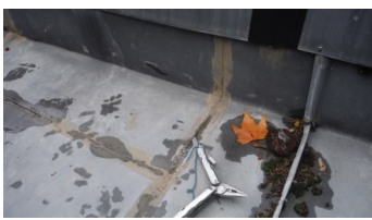
Zinken dakbedekking met lichte golfvorming.
