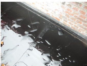
Door blaasvorming zal de dakbedekking sneller verouderen en is het risico op mechanische beschadiging en lekken groter.
