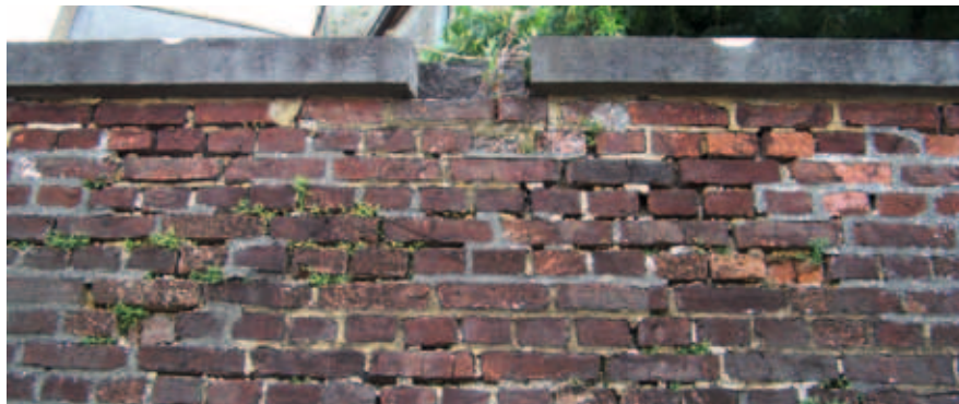
Een beschadigde deksteen geeft extra waterinsijpeling.
