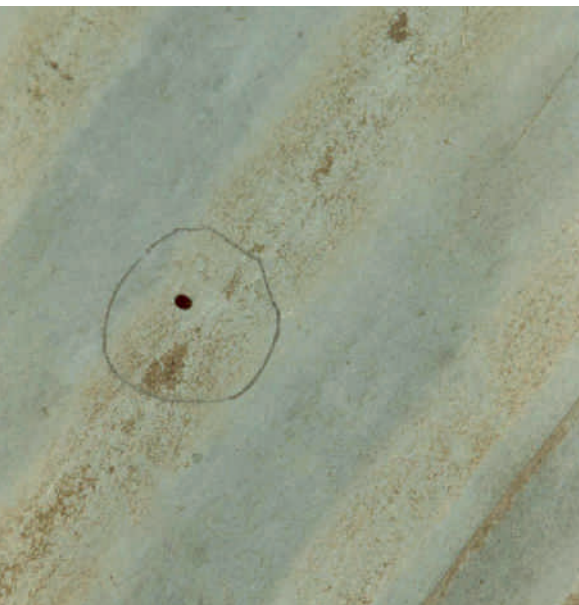
Uitvliegopening in loden gootopstand
