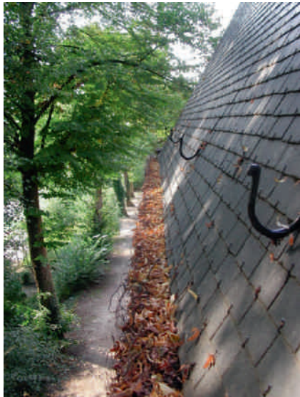
Goten moeten regelmatig gereinigd worden
