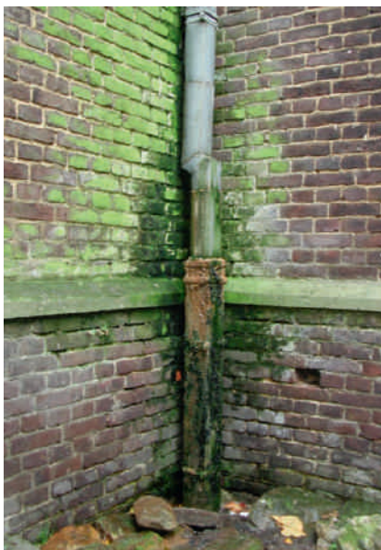
Nat en bemost metselwerk wijst op verstopping
