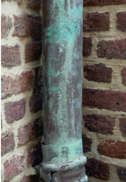
Gecorrodeerd koper
