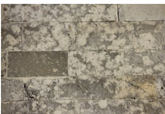
Na het verwijderen van mossen kan een geëst geveloppervlak achterblijven.
