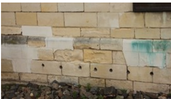
Een combinatie van verschillende foutieve restauratiekeuzes laat hier blijvende zichtbare sporen na.
