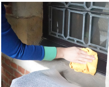
Reinig samen met het glas in lood het schrijnwerk. ⑧
