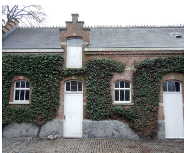
Regelmatig bij snoeien voorkomt dat de klimplanten in de dakgoten of voor de ramen groeien
