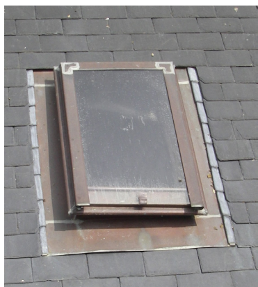
Zorg voor een goede wind- en waterdichte randafwerking. ④
