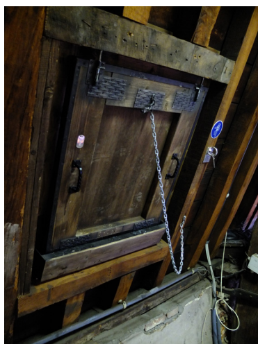
Breng stevige handgrepen en een valketting aan bij torenluiken. ① ②
