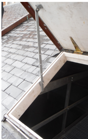
Een voldoende grote opening en een uitzetijzer zorgen voor een gemakkelijker doorgang. ③
