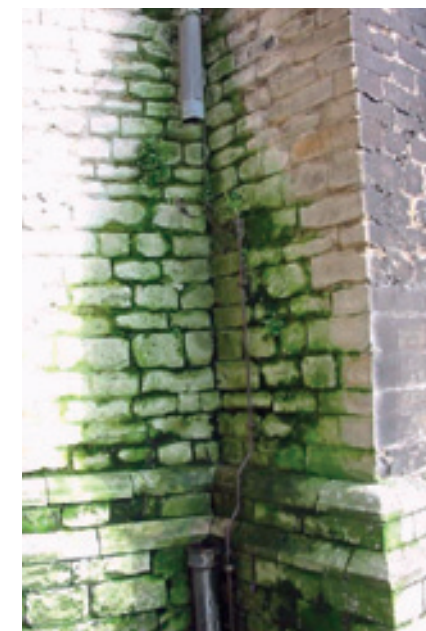
Door een mankement in de regenwaterafvoer zijn de voegen permanent vochtig en kunnen er mossen en algen groeien.
