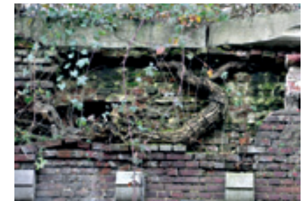
Wortels in de voegen groeien, verhouten en drukken het metselwerk stuk.
