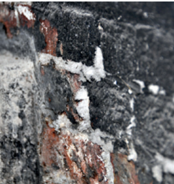
Zouten in gezond metselwerk bloeien uit op de voegen.
