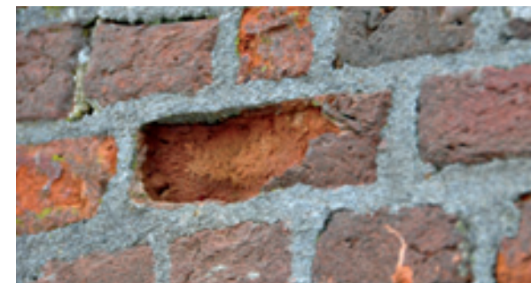
Een foute keuze voor een te cementrijke herstellmortel heeft het vochttransport verlegd naar de bakstenen, waardoor bakstenen beschadigd raken.
