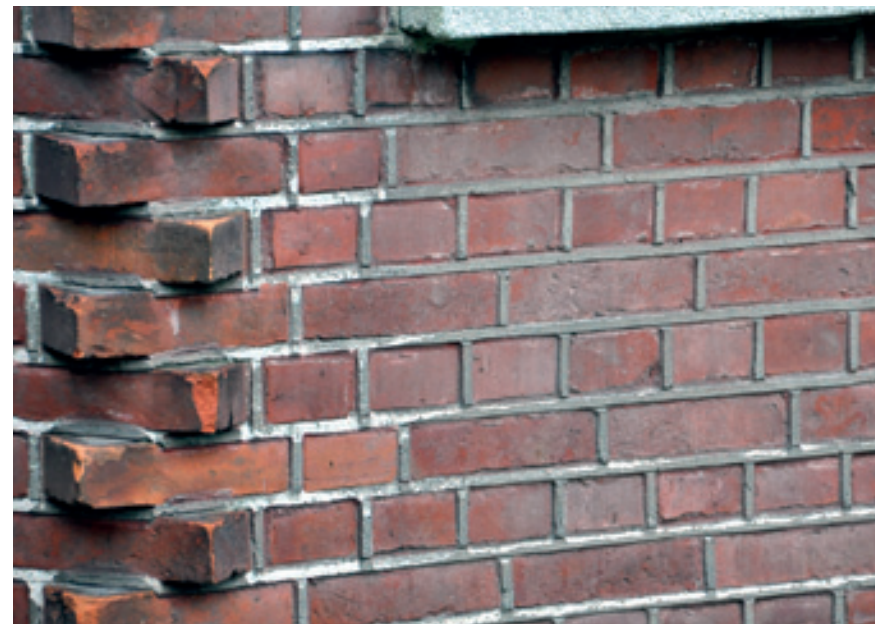
Het voegwerk onder een vensterdorpel met goed werkende druiplijst heeft minder te lijden onder erosie.
