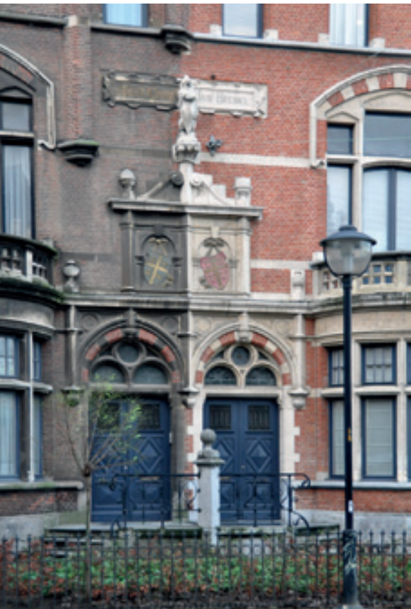
Een gereinigde gevel krijgt een frisse look, maar heeft vaak beschadigingen aan (bak)stenen en de profilering van het voegwerk opgelopen.
