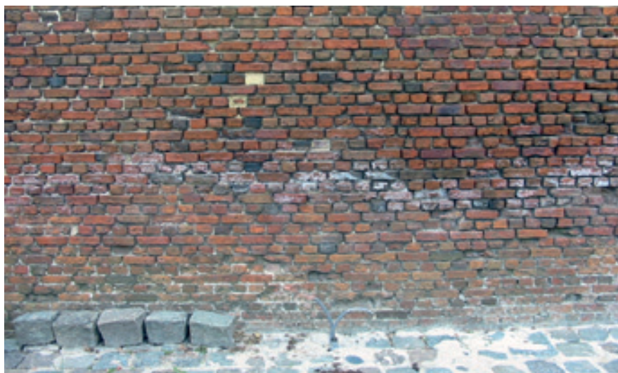
Optrekkend vocht beschadigt het voegwerk.
