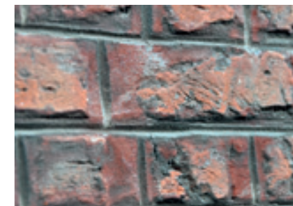
Door de streep in het voegwerk lijkt het metselwerk regelmatig. De mortel buiten de streep werd bijgekleurd in de kleur van de baksteen.
