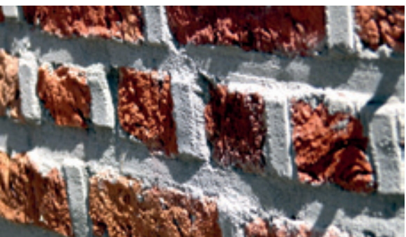
Een gereinigde gevel krijgt een frisse look, maar heeft vaak beschadigingen aan (bak)stenen en de profilering van het voegwerk opgelopen.
