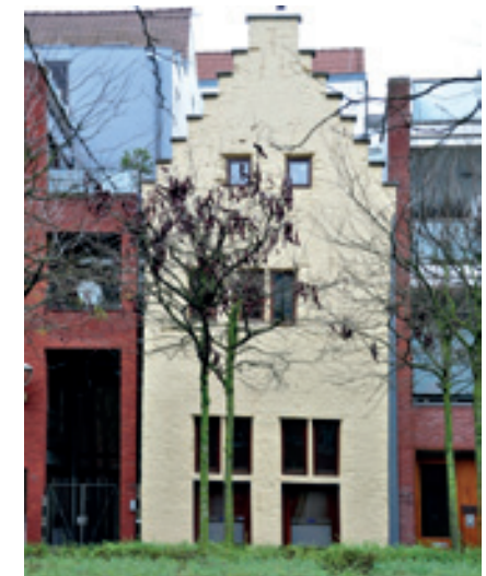
Verzakkingen werden opgevangen zonder grote scheuren in het 'zachte' metselwerk.
