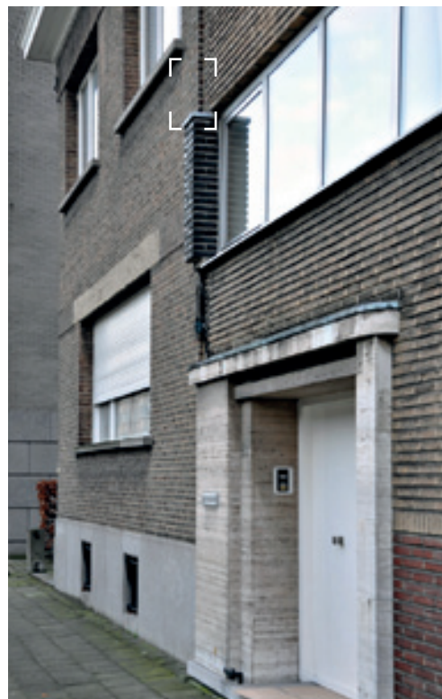
Twee aanpalende gebouwen met nagenoeg hetzelfde (verkleurde) type baksteen. Samen met de vorm van de ramen bepalen de voegen (links knipvoegen, rechts verdiepte lintvoegen en platvolle gekleurde stootvoegen) het uiteenlopende karakter van de gevels.
