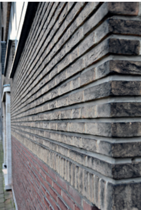
De verdiepte lintvoegen accentueren het horizontale karakter van de gevel. De stootvoegen werden platvol gevoegd in de (oorspronkelijke) baksteenkleur.
