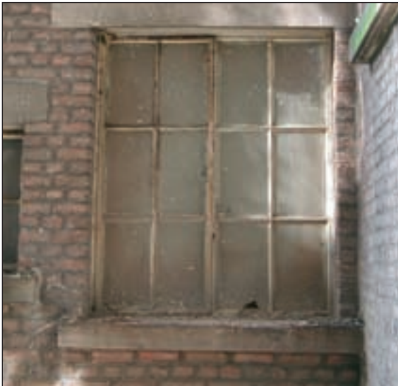
Corrosie door onvoldoende onderhoud
