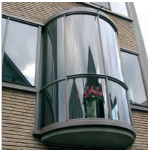
Stalen ramen - ook met een speciale vorm - zijn perfect te herstellen in een atelier
