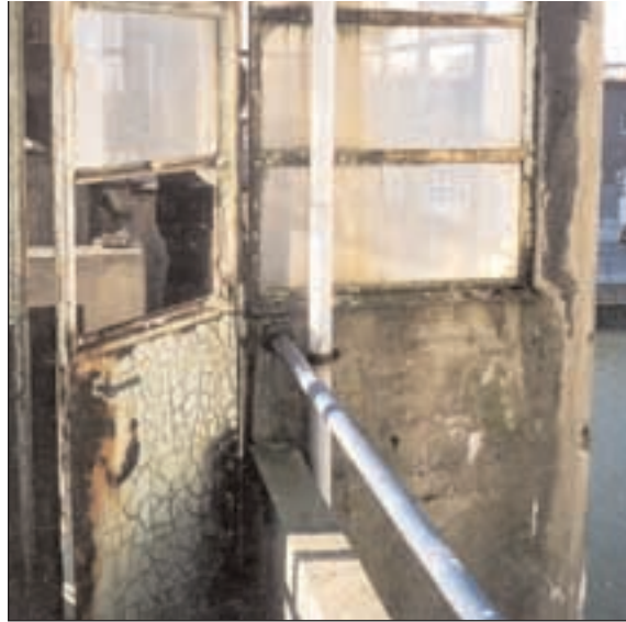
Combinatie van verschillende schadebeelden
