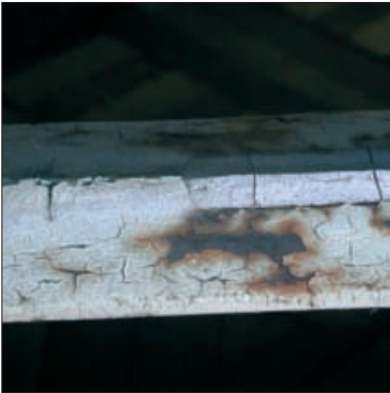
Staal gaat roesten onder afbladderende verf
