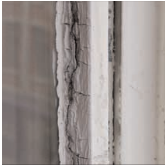
Gebarsten en uitgeharde stopverf
