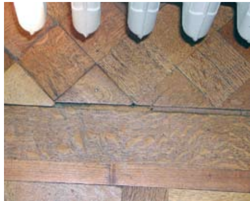
Krimp van parketdeeltjes onder een radiator is een veel voorkomend schadeverschijnsel
