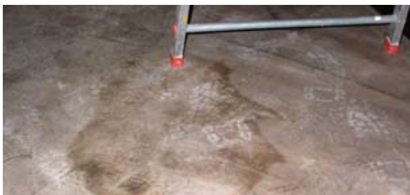
Onbeschermde vloer tijdens werkzaamheden
