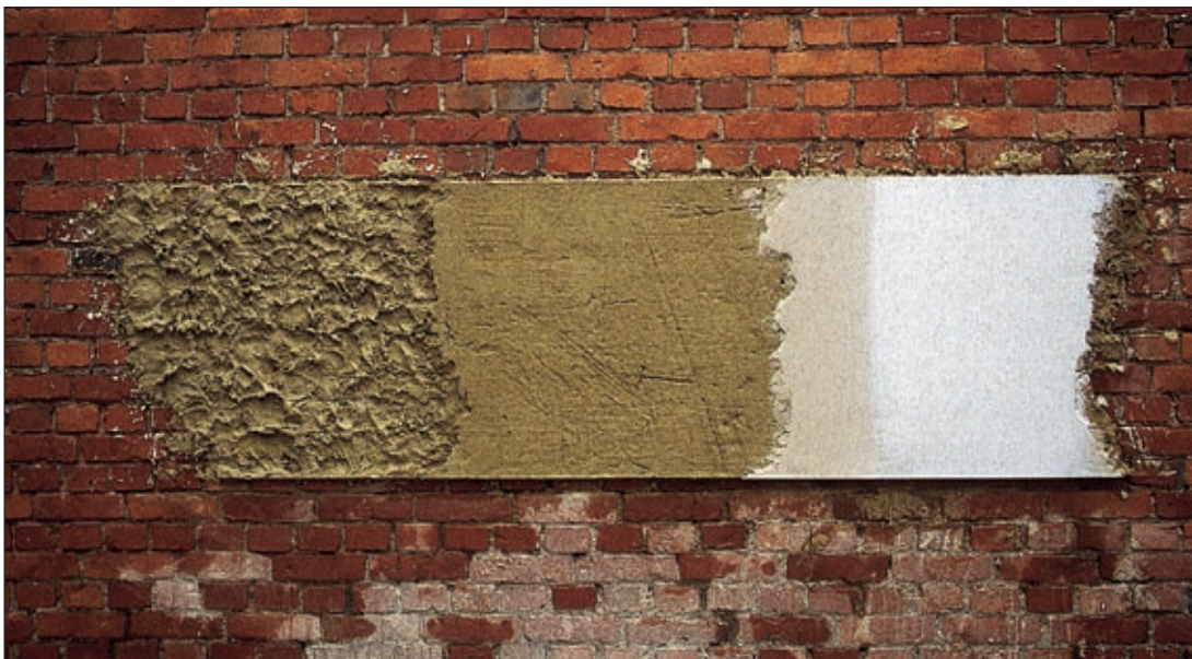
◀ Het eindresultaat met van links naar rechts: de spritlaag, de raaplaag, de afwerkingslaag en de kaleilaag.
