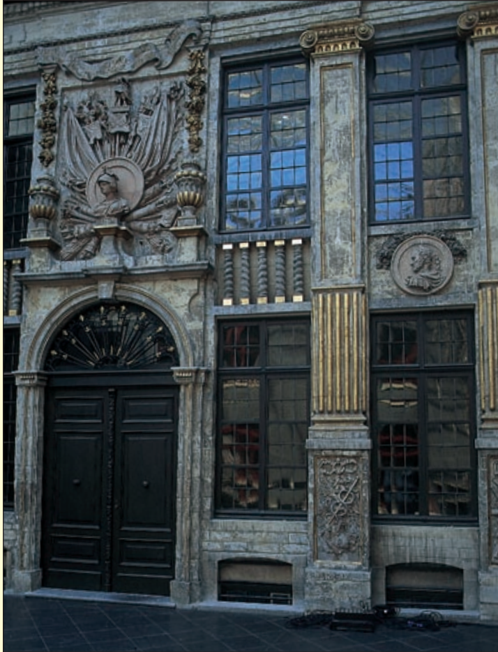
▲ Bij de restauratie van de laat-17de-eeuwse gevel van het Bellonehuis te Brussel werden de resten van de oorspronkelijke polychromie zorgvuldig blootgelegd en geconserveerd.
