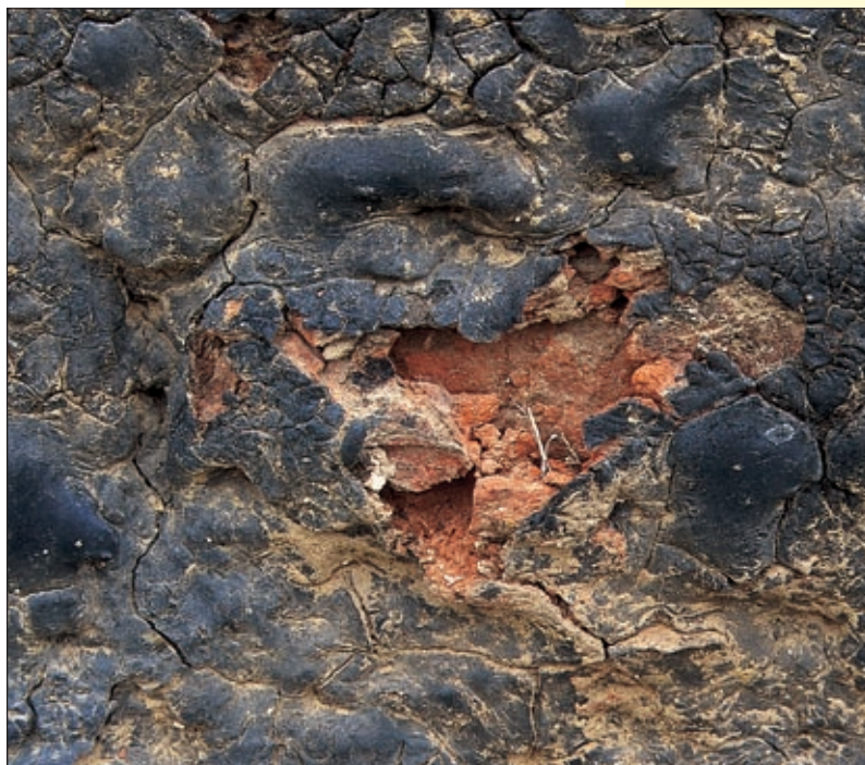
▲ Vorstschade aan het baksteenmetselwerk achter een oude afgeteerde plint.
