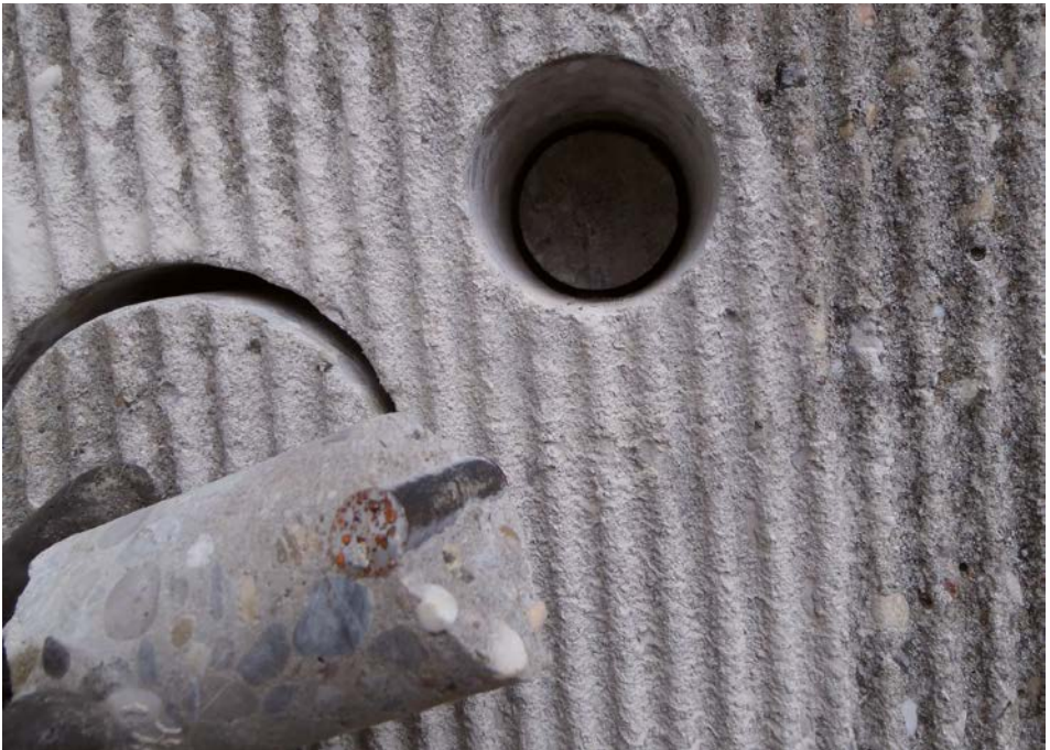
▲ Betonkern geeft informatie over beton en wapening
