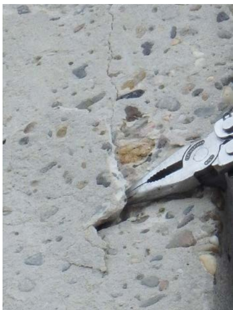
▲ Oorzaak scheurvorming onderzoeken
