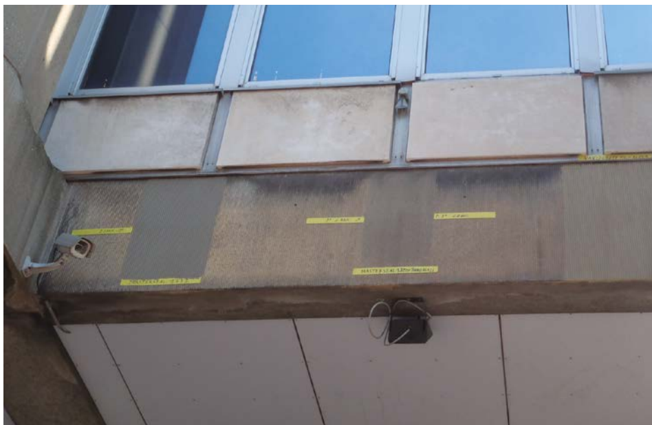
▲ Voorzie voldoende proefvlakken om mogelijke afwerkingen een tijdje op te kunnen volgen
