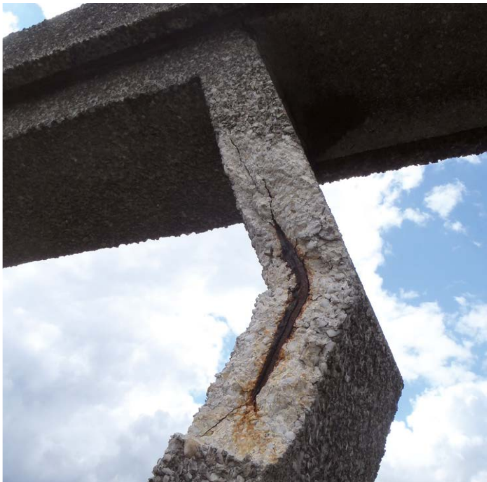
▲ Wapeningscorrosie ten gevolge van carbonatatie
