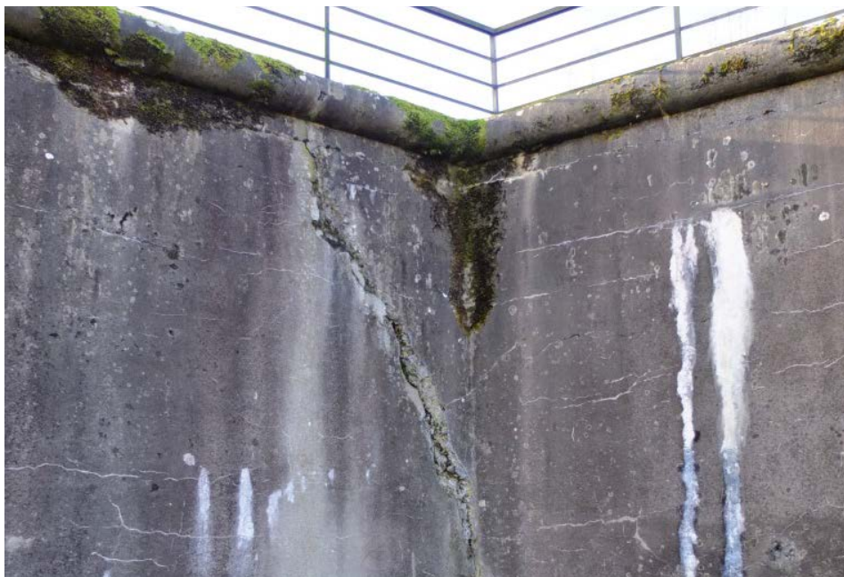
▲ Massieve constructie met verschillende scheuren. Mossen wijzen op een verhoogde vochtbelasting
