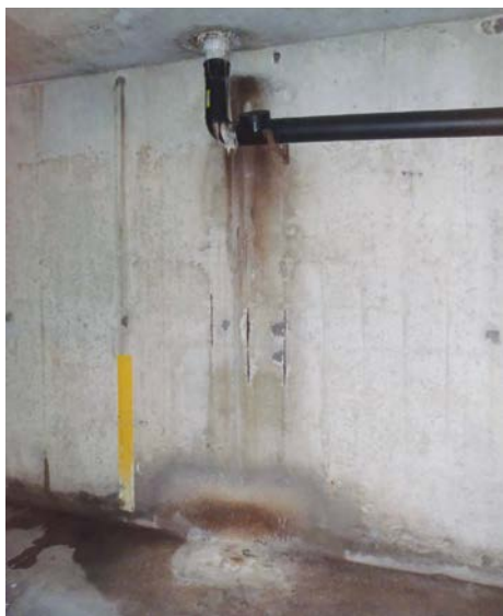
▲ Een lek in de waterafvoer zorgt voor betonaantasting
