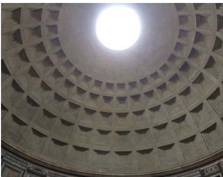
▲ Betonnen koepelgewelf, 2de eeuw, Pantheon, Rome
