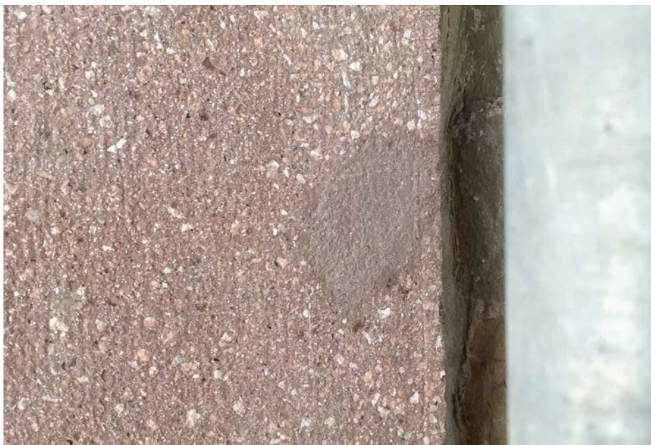
▲ Origineel oppervlak en herstelling gebouchardeerd
