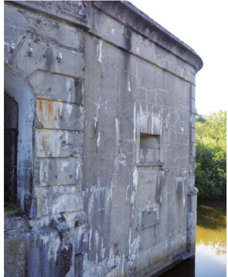
▲ Massief betonnen fort
