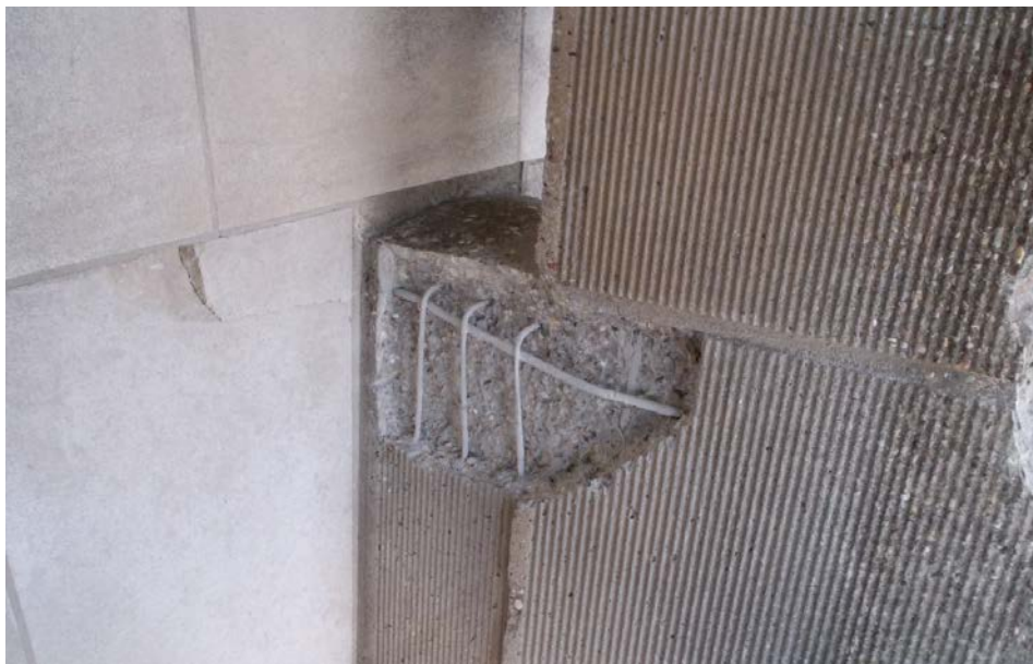
▲ Wapening behandelen tegen corrosie
