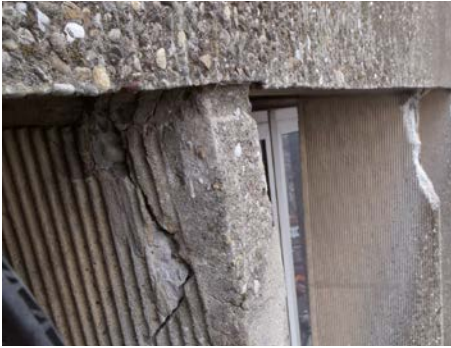
▲ Door vertering krijgt het geprofileerde beton een 'gewassen' afwerking
