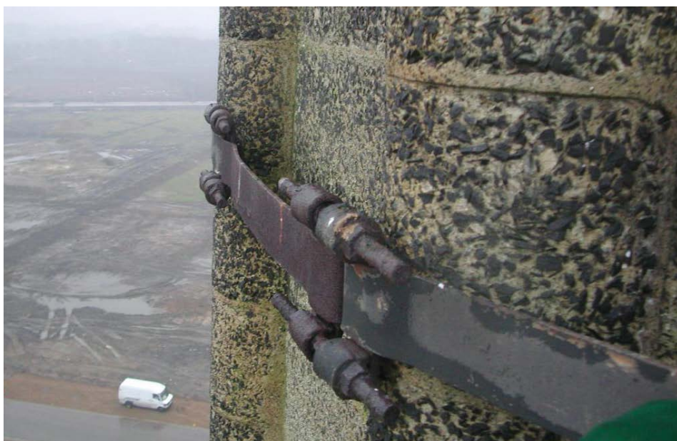
▲ Ga na of de constructie vlot bereikbaar is om een aangebrachte afwerklaag regelmatig te hernieuwen
