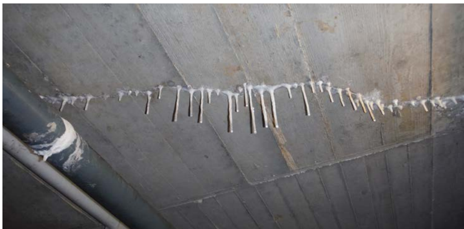
▲ Uitloging van kalk in betonconstructie
