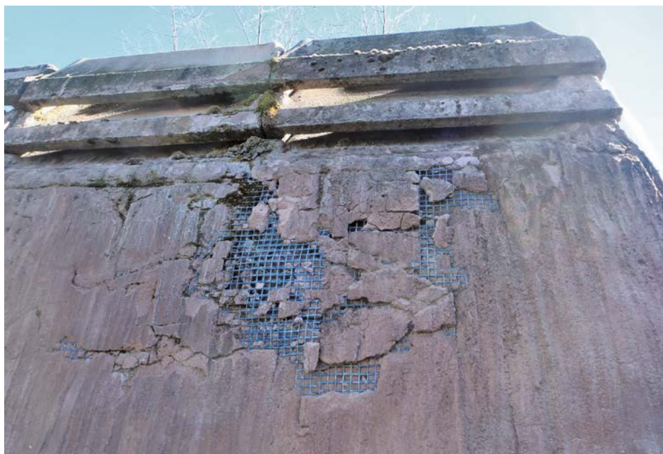
▲ Tijdig herstelde voegen tussen de dekstenen had schade kunnen voorkomen of beperken
