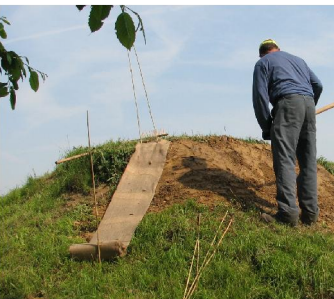
Kale plekken worden afgedekt, bv. met jutte en aangeplant. De doeken beschermen tegen erosie tot de planten voldoende groot zijn.
