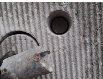
Een betonnen boorkern (op een weinig storende plaats) geeft informatie over de samenstelling en toestand van het beton.
