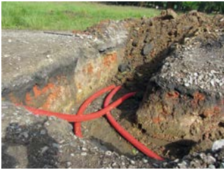
Aanleg van ondergrondse nutsleidingen
