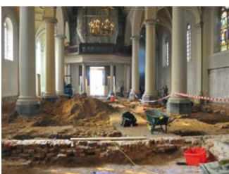
Opgraving in een kerk voor de aanleg van vloerverwarming
