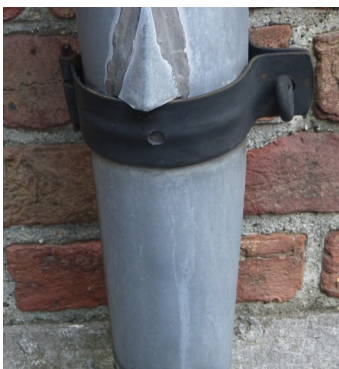
Controleer of de (scharnier-) beugels goed vast zitten. Een neus voorkomt dat onderdelen van de afvoerbuis verzakken.
