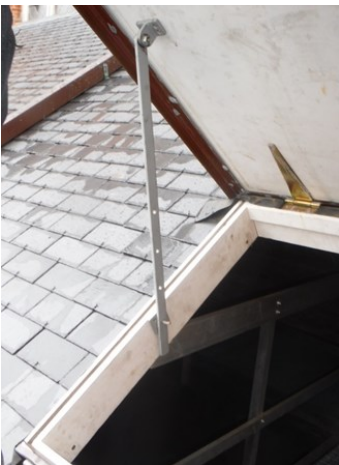
Een voldoende grote opening en een uitzetijzer zorgen voor een gemakkelijker doorgang. ③
