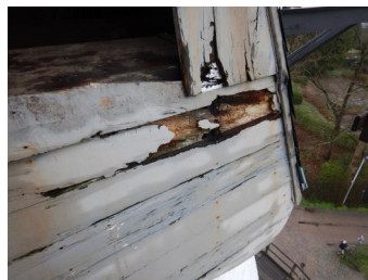
Sterke inrottingen door achterstallig schilderwerk.
