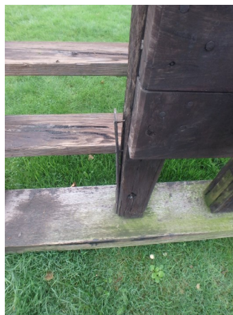
Verweerde verflagen op trap treden.
